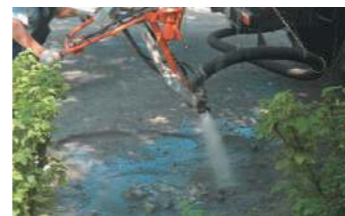
Промывка ямы водой
